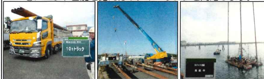
写真1. 搬入状況 写真2. スパット台船組立状況 写真3. スパット台船曳航状況
